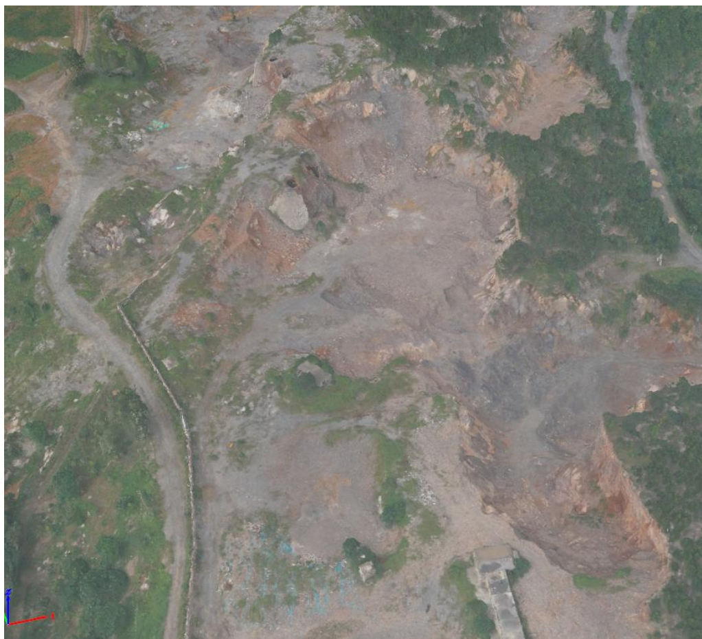
照片 3-4 表土堆放场现状
