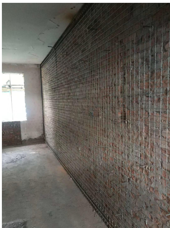
外加钢筋网-砂浆面层
